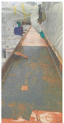
高知県・寺内橋 剥離作業中
