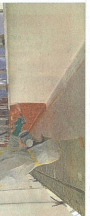
高知県2021年6月 寺内橋 353㎡ ストリップパーによる塗膜剥離作業
