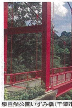
泉自然公園いずみ橋(千葉市発注、2017年12月施工)
