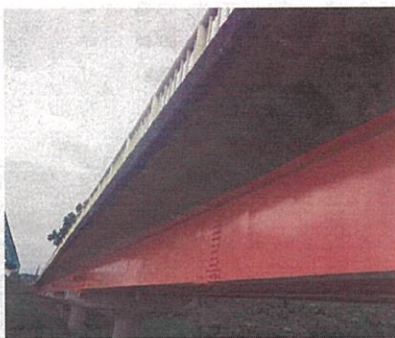
神戸大橋(埼玉東松山山市発注 2016年12月施工)
