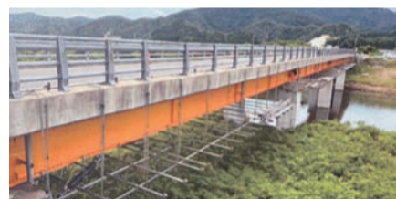
施工事例(兵庫県)の橋梁補修工事
