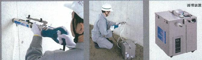
躯体構造のジャンカ、浮き、ひび割れ、及び調整モルタル・タイル貼付けモルタルを完全一体化する事を目的とした工法です。
