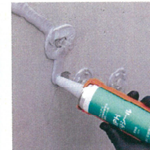
台座取り付け部以外のひび割れにシールします。
