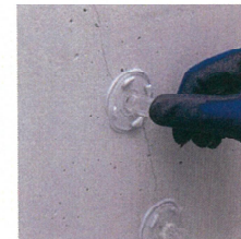
注入ポイントに台座を取り付けます。
